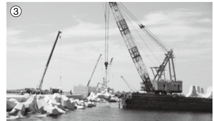
現在進められている護岸工事の状況。①捨石均し状況(2016年6月撮影)、②裏込材投入状況、③消波ブロック据付状況(ともに同10月撮影)。写真提供:内閣府沖縄総合事務局
